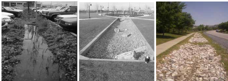
Figura 28 – Esempi di trincee d’infiltrazione
